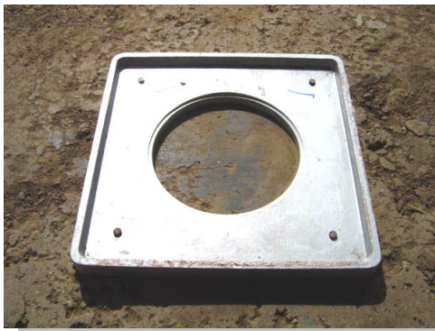
รูปที่ 9.6 แสดงการวางแผ่นฐานและตอกตะปูที่มุม รูปที่ 9.7 แสดงการสกัดดินตรงกลางแผ่นฐานรอง ภาพโดย : มานิต ช่วยงาน ก.ค. 2552
